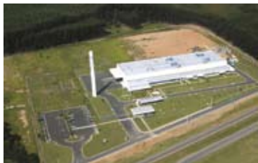
Unidade Filtros Mogi Guaçu
